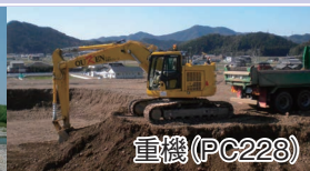
各務原大橋下部工
