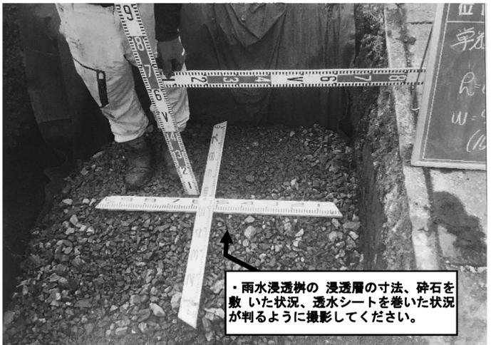
・雨水浸透柵の浸透層の寸法、碎石を敷いた状況、透水シートを巻いた状況が判るように撮影してください。
