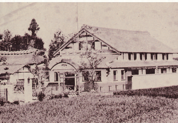
写真2 明治8年に新築された敬恪学校 （『岐阜県管内学校撮影』より 宮内庁書陵部所蔵）
