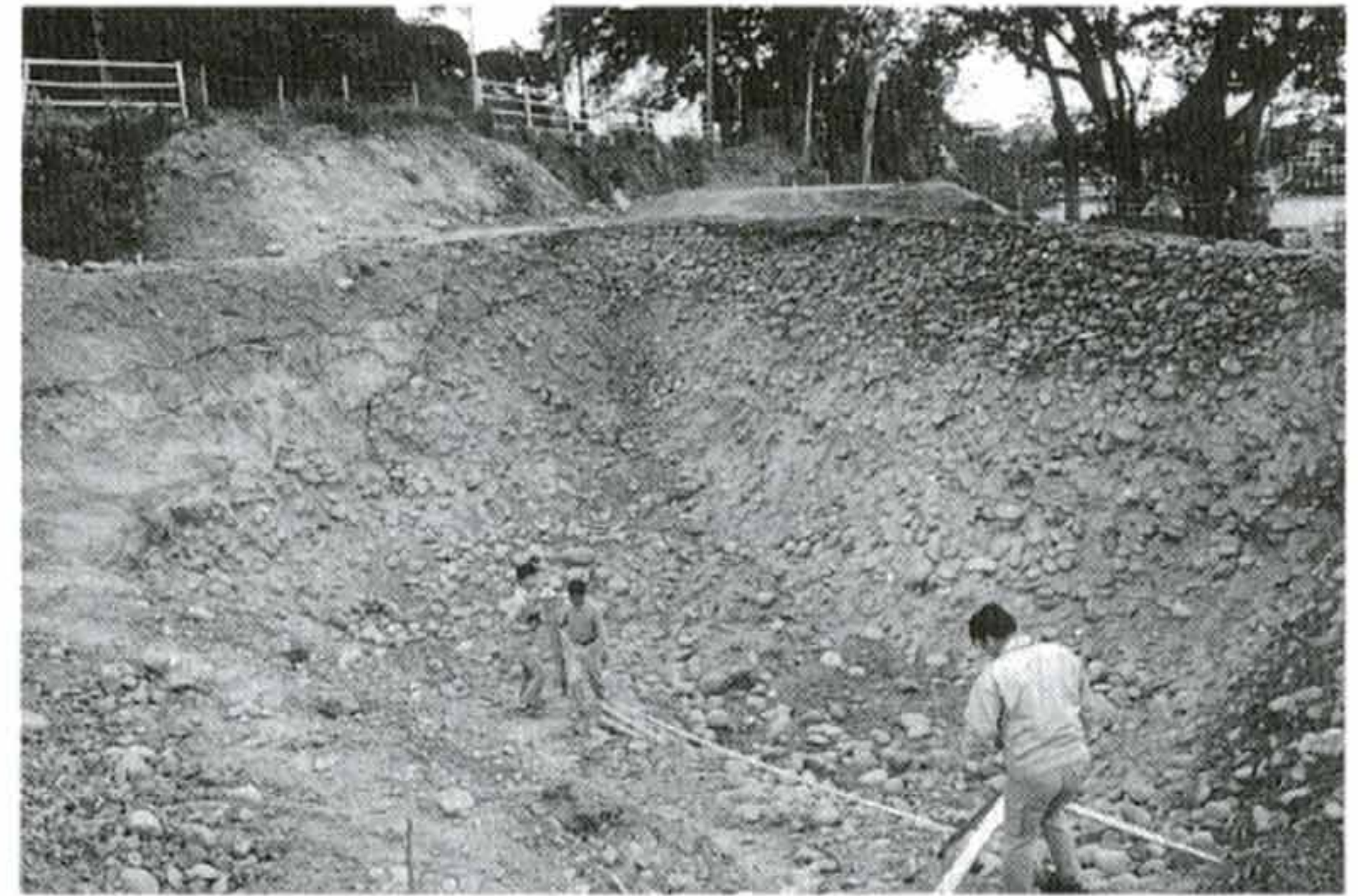
前渡猿尾堤調査風景
