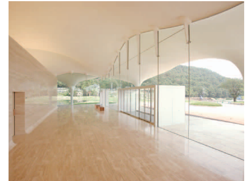
エントランスホール
