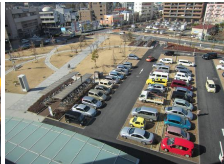
防災広場やイベント広場としても使用できる駐車場／青梅市
