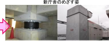
免震構造など、総合的な防災拠点と して十分な耐震性能を持つ構造に など十分なバックアップ機能を備えます
