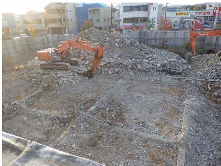
正面玄関ポーチの解体に続き、本庁舎南側の低層部の解体に着手し、建物上屋部分の解体が完了しました。
