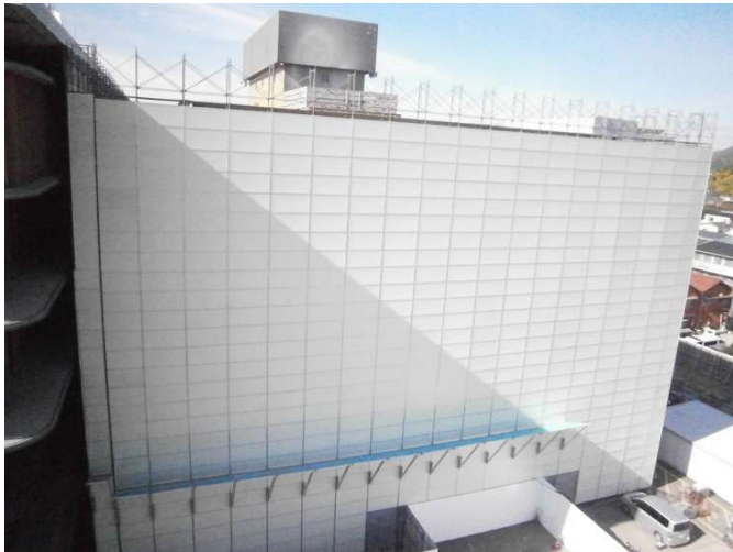
《旧庁舎東面写真》
