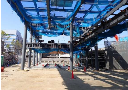
柱や梁の組立工事中
