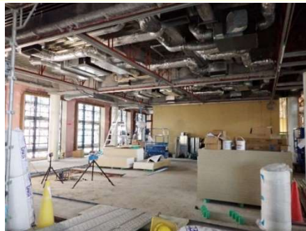
空調配管工事中
