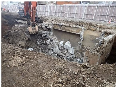
地下埋設物の撤去作業
