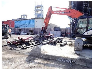
廃材の分別作業
