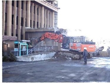
旧庁舎北側外壁の解体作業
