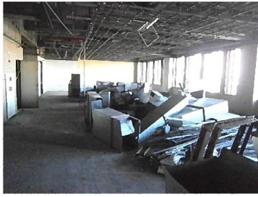
内装の解体作業
