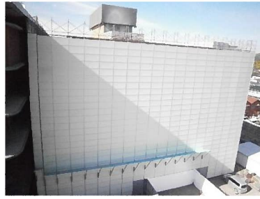
パネルで囲まれた旧庁舎
