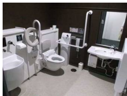
事例：多目的トイレ（半田市）
