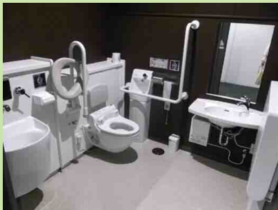
事例: 多目的トイレ(半田市)
