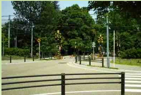
敷地北側踏切
