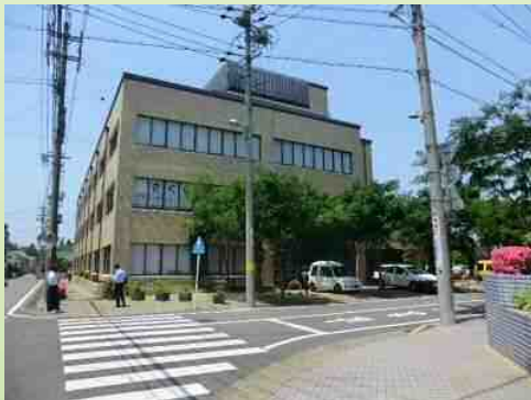
東側建物外観
