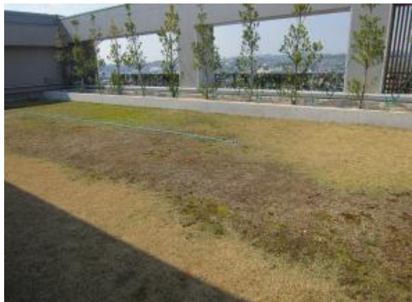
貯留雨水を利用した屋上緑化
