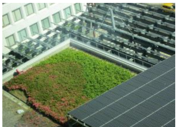
屋上緑化と太陽光パネル
