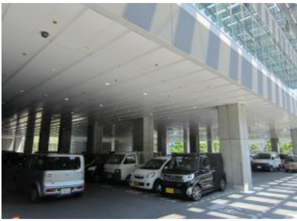
庁舎1階部分にある駐車場
