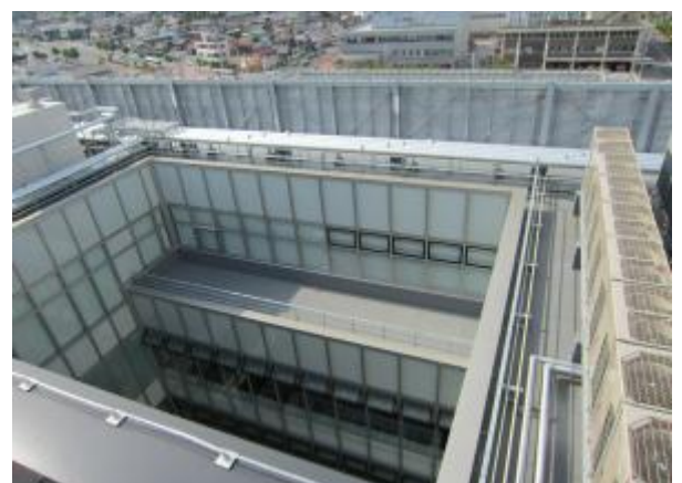
吹抜け構造上部
