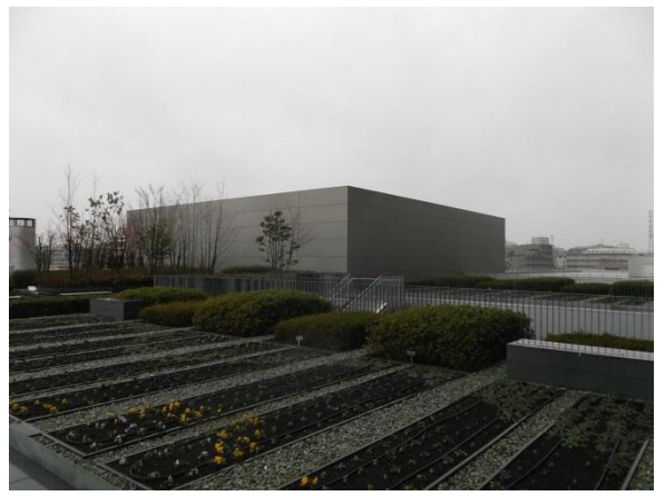
3階屋上緑化(市民団体管理)
