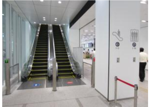
1階正面入口付近のエスカレーター
