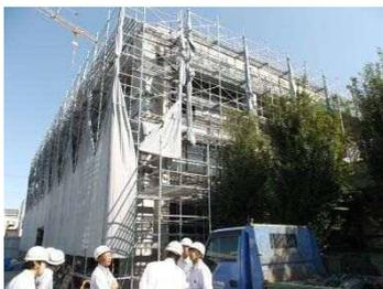
PCアウトフレーム、鉄骨ブレース施工箇所（西庁舎西面・南面）
