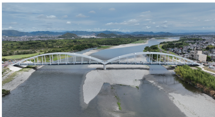
完成が待ち望まれる川島大橋（令和 8 年 8 月 29 日時点）
