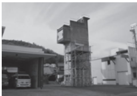
解体される北分署の高層訓練塔
