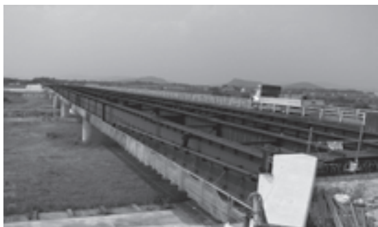
建設中の(仮称)新小網橋
