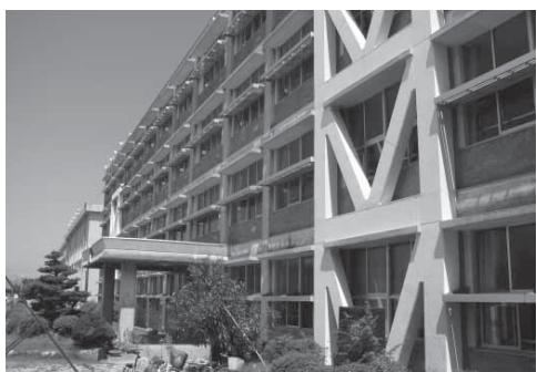
学校耐震補強（川島中）
