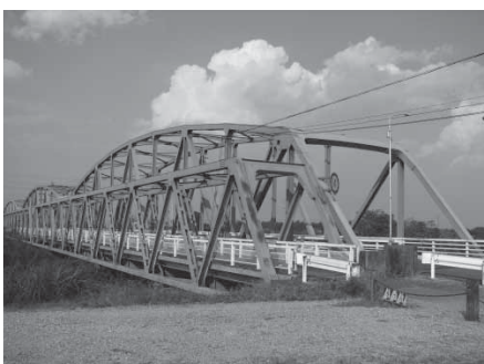
トラス構造の河田橋
