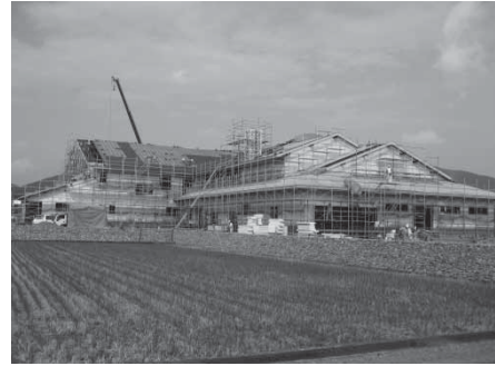
建設が進む学校給食センター
