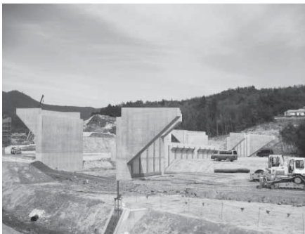
工事中の坂祝バイパス周辺
