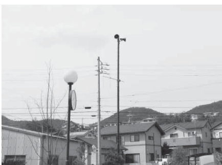
市内一円に設置された災害情報スピーカー
