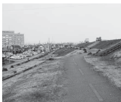
木曽川堤防(笠松町)
