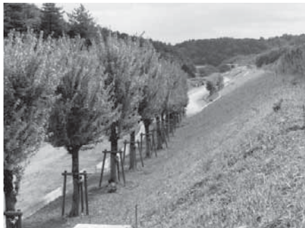
工事中の坂祝バイパス
