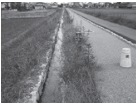
羽島用水上部に整備された歩道・水路
