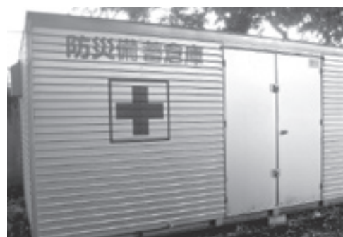
避難所に設置している防災倉庫
