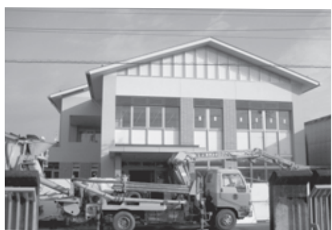
建設中の稲羽コミュニティセンター
