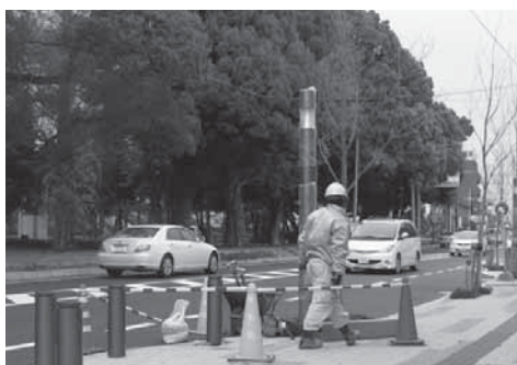
那加メインロード整備（市民公園南側）
