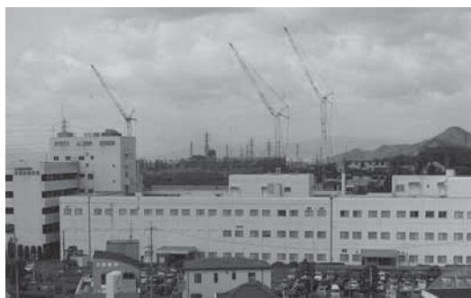
建設中の東海中央病院（写真奥）
