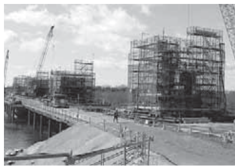
各務原大橋橋脚工事現場
