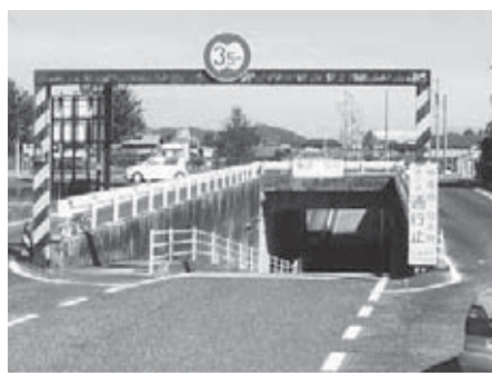
国道21号線のアンダーパス(三井東町)
