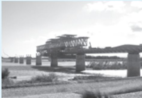
建設が進む各務原大橋
