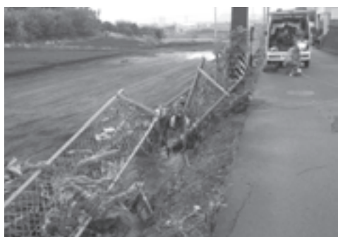
8月23日の豪雨による被害現場(鵜沼丸子町)
