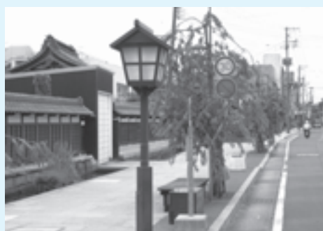
整備された歩道（新発田市）
