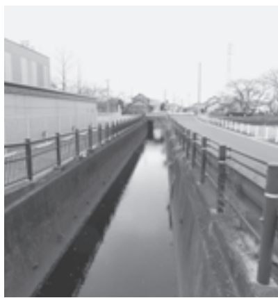
排水路（那加市下町）
