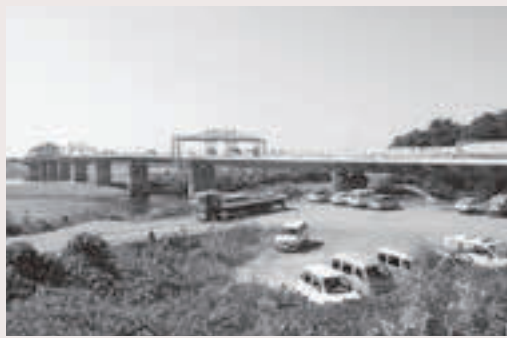
建設が進む各務原大橋（上中屋町）
