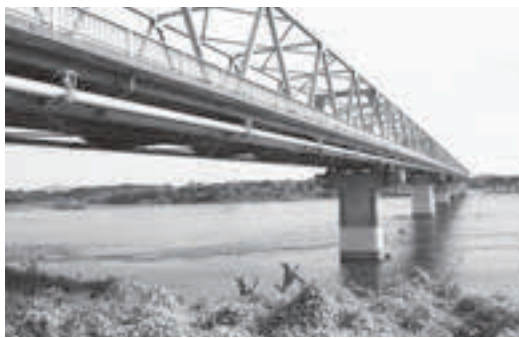
補修工事を終えた愛岐大橋
