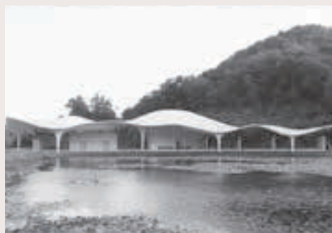
火葬炉を1基増設した市営斎場
