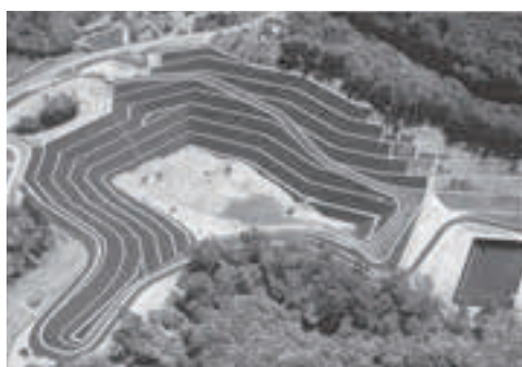
最終処分場(群馬県草津町)
