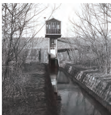
改築予定の小網樋管
