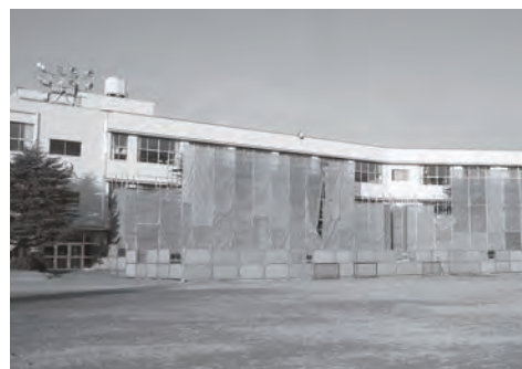
校舎耐震補強工事（稲羽中学校）
