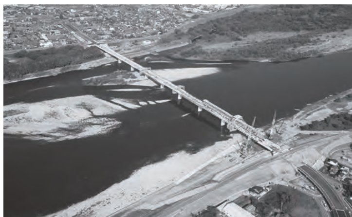
建設中の各務原大橋
