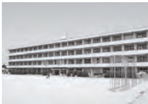
耐震補強工事を行う川島小学校
