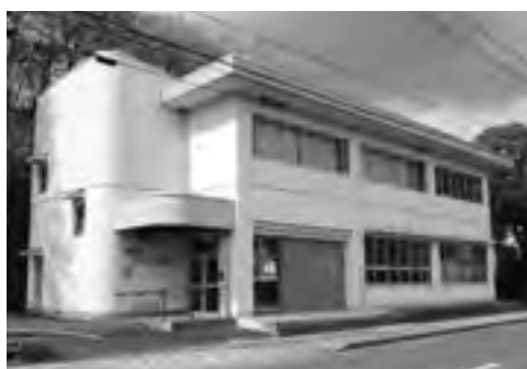
改修予定の松が丘コミュニティセンター
