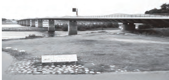
完成した各務原大橋（上中屋町）
