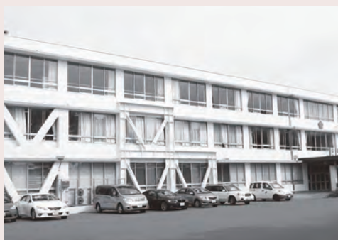
耐震補強された那加中学校校舎
