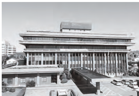
耐震改修基礎調査中の本庁舎
