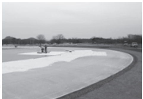
整備中の陸上競技場（上中屋町）
