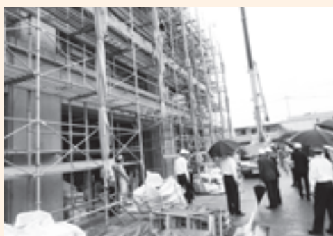
建設中のPCアウトフレーム（江南市）
