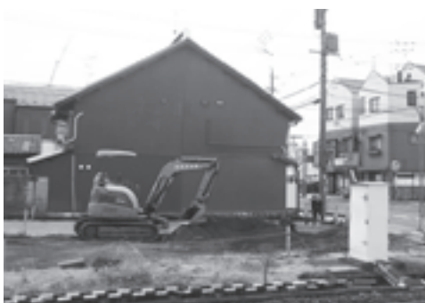
整備中の駐輪場(JR 那加駅南)
