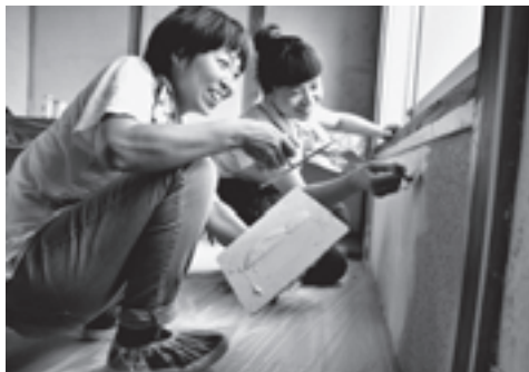
DIYで空き家を自分好みに修繕
