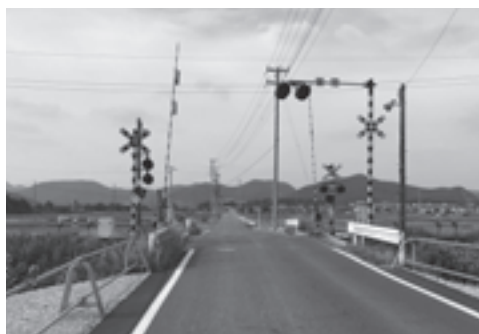
工事を行う JR 高山本線濃川踏切
