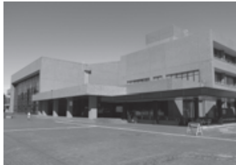
舞台照明設備を更新する市民会館
