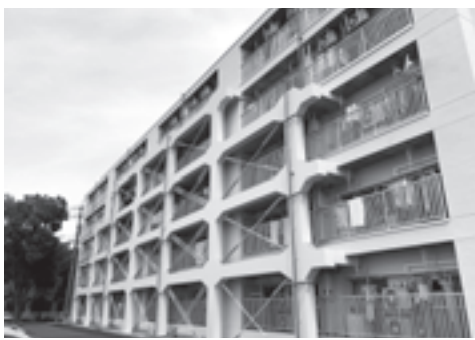
耐震補強フレームを設置したA棟
