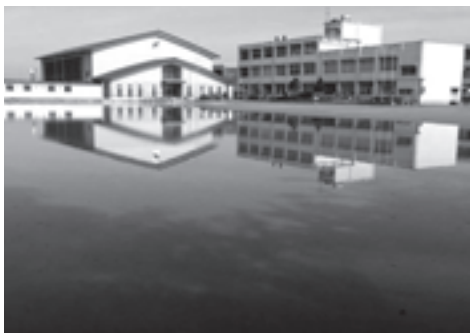
校庭貯留施設（稲羽西小学校）
