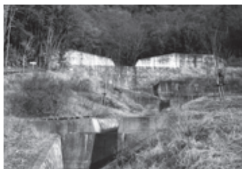
治山工事が行われた松が丘地区
