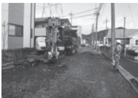
道路維持補修作業の様子
