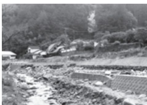
傷跡が残る杷木松末地区（朝倉市）
