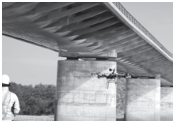
各務原大橋の点検でドローンを活用
