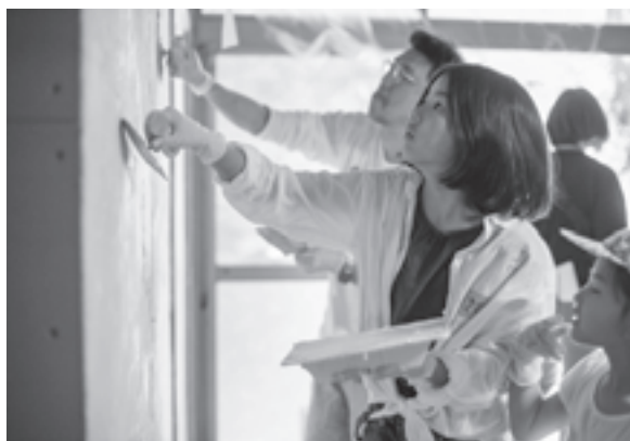
空き家の借り主が自らの手で改修
