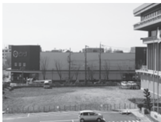
新庁舎建設のため更地となった現庁舎南側
