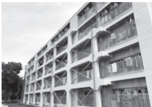
すでに耐震補強を行ったA棟
