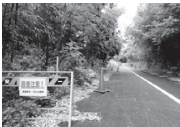
再整備を行うサイクリングコース
