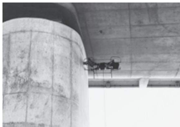
橋脚の打音検査を行うドローン
