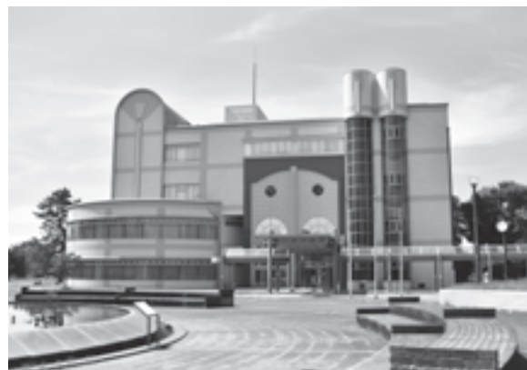
開館から28年が経過した中央図書館
