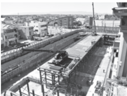
地盤改良が終わり地下の工事が進む新庁舎
