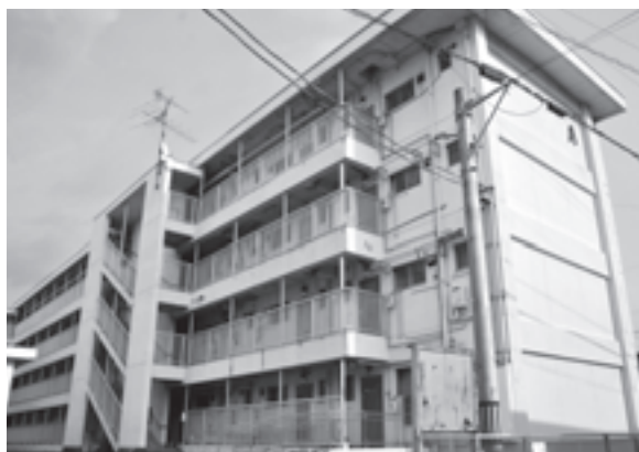
耐震補強工事を行う旭ヶ丘住宅A棟
