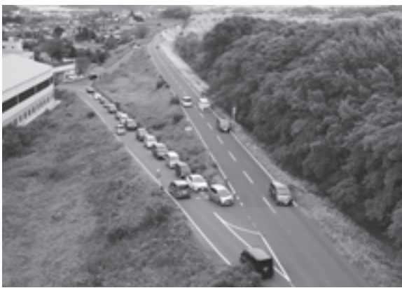
鋭角に交わり見通しが悪いため改良予定の交差点
