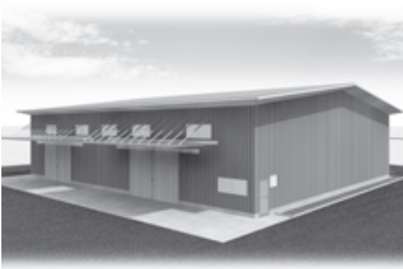
鵜沼朝日町に新たに建設される防災備蓄倉庫
