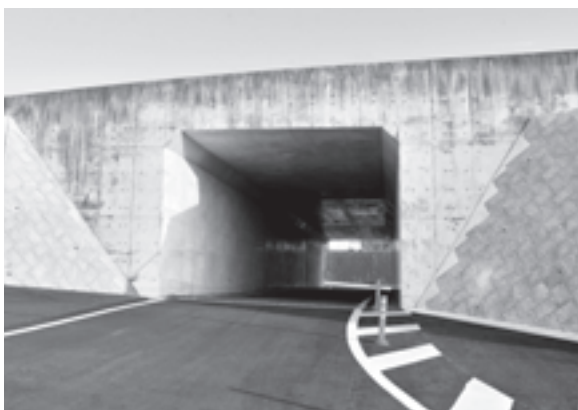
（仮称）新愛岐大橋の取付道路の下を通る新たな市道
