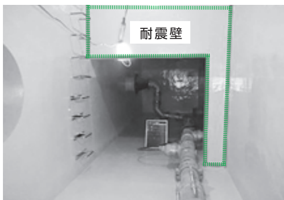
令和元年度に耐震壁の工事を行った松が丘受水池の内部
