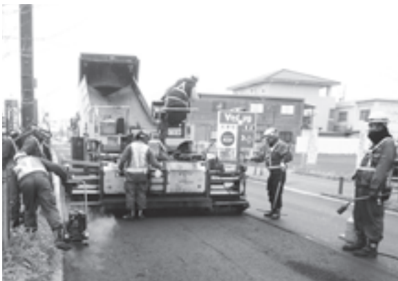
市が発注する道路工事
