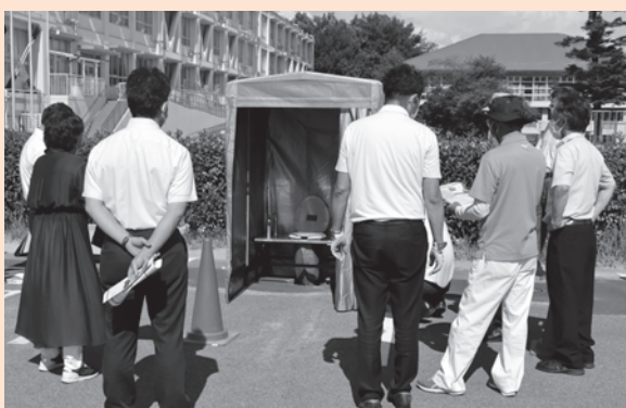
マンホールトイレの組み立て作業を確認する委員
