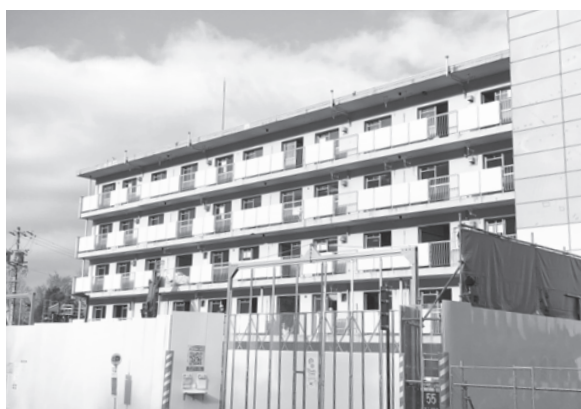
工事が進められている UR 緑苑東団地
