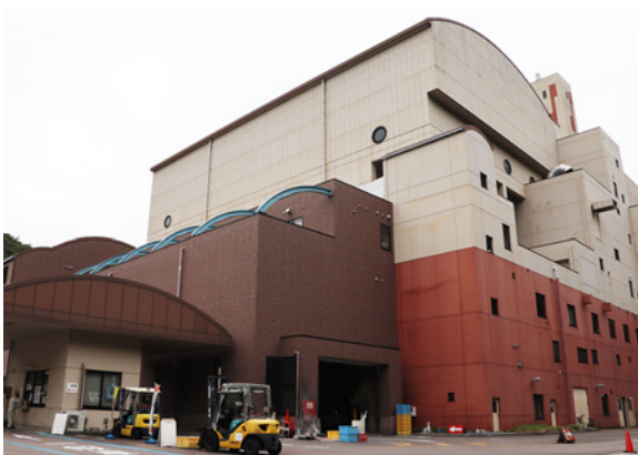
設備の改良工事が行われる北清掃センター
